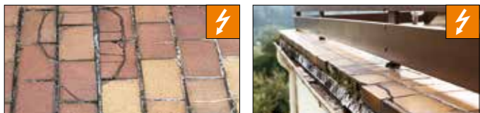
Estos desperfectos pueden evitarse con el sistema Schlüter para balcones
